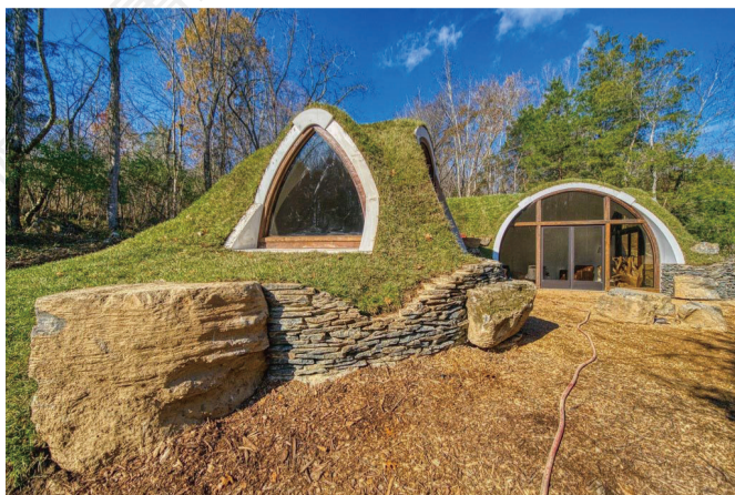
图 6-52 低能耗的覆土建筑 图源：TREE TOP BUILDERS 公司
