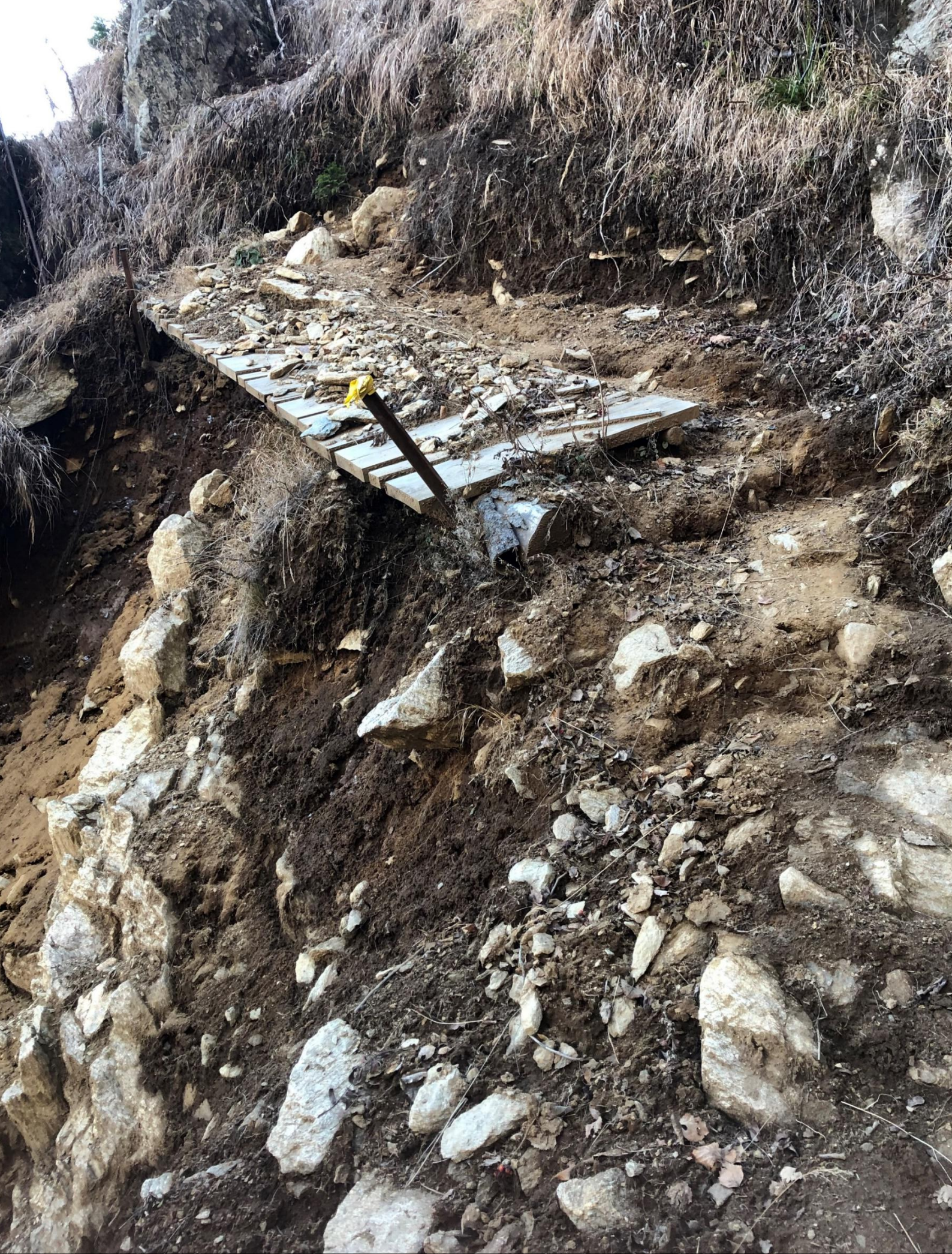
拍摄©高宁 Serge Koenig : 阿尔卑斯山霞穆尼区域一条小径被泥石流造成的损毁路段(法国)
